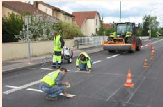
La sécurisation des accès sur la voirie par la signalisation au sol
