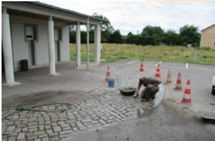
Des travaux de dallage à la salle polyvalente
